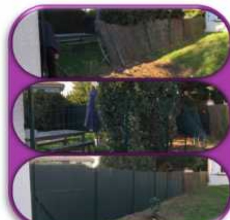
Réparation d'une clôture
